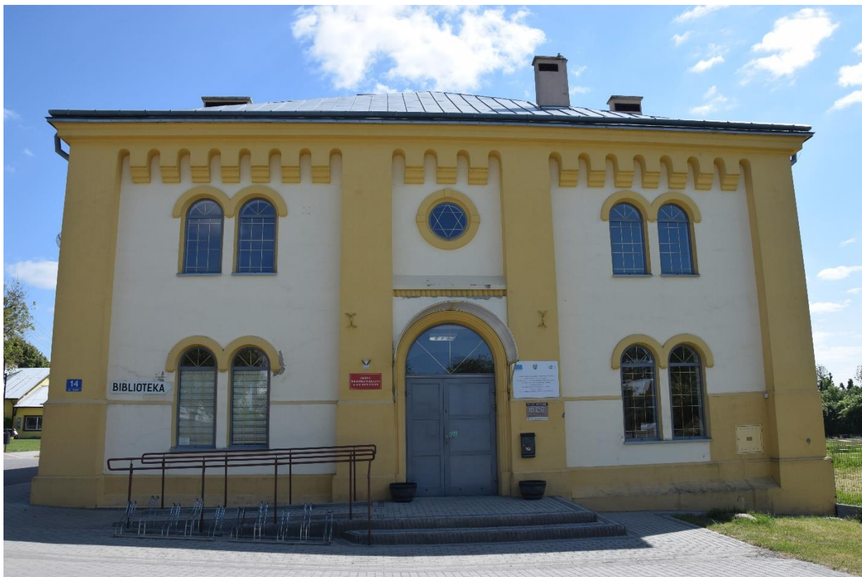
Fot. Elewacja zachodnia budynku. Stan zachowania na 2024 rok
