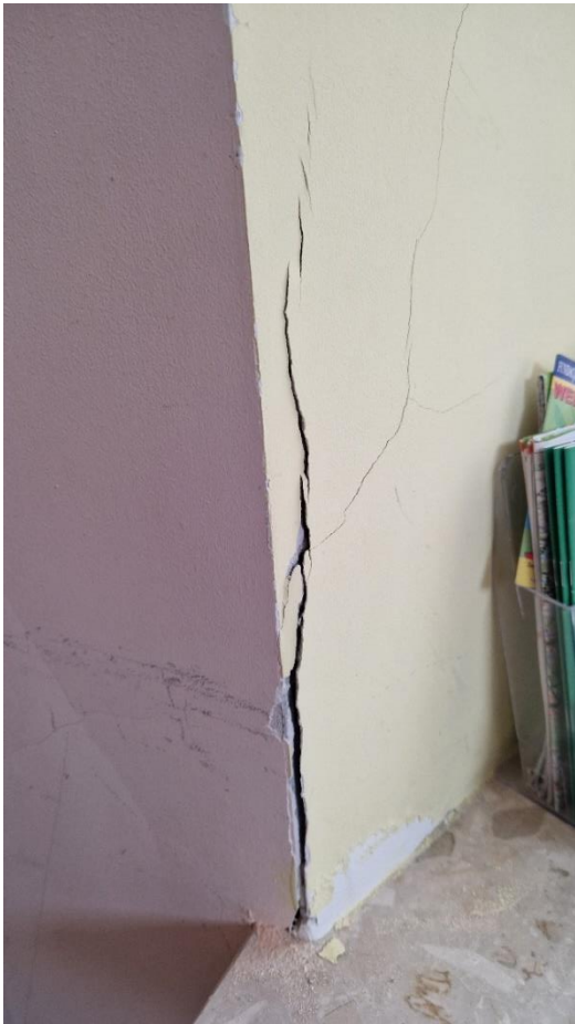
Fot. Zniszczony tynk wewnątrz budynku. Stan zachowania na 2024 r.
