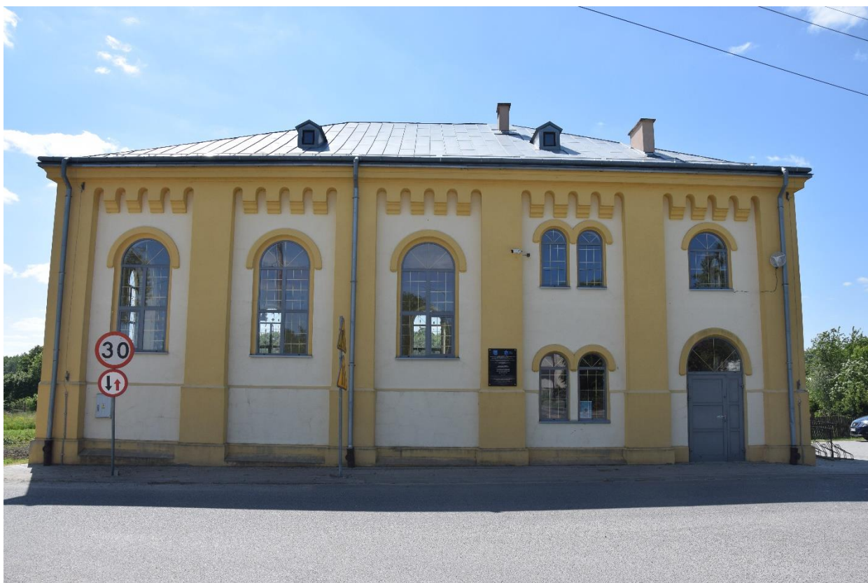
Fot. Elewacja północna budynku. Stan zachowania na 2024 rok.
