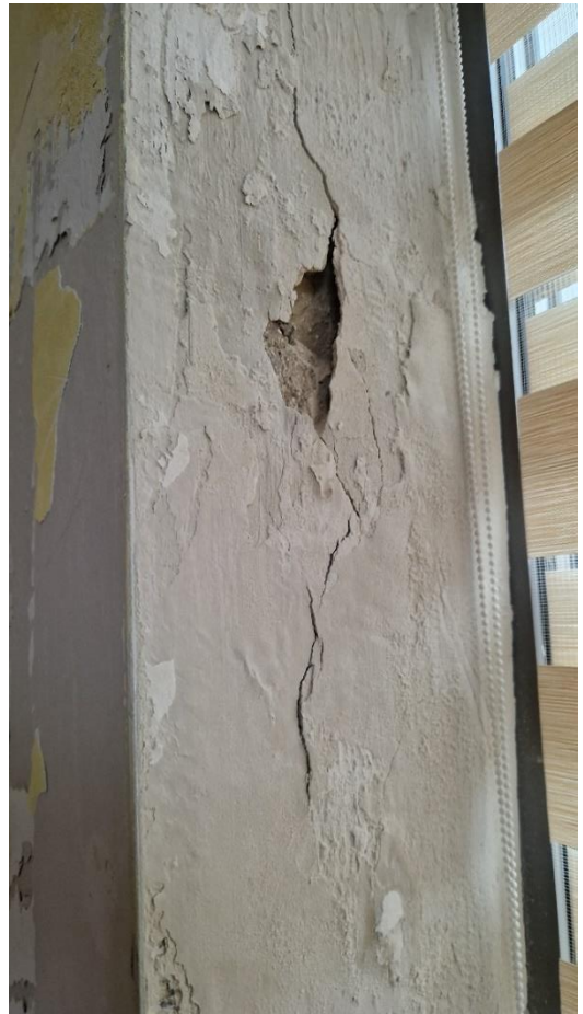
Fot. Zniszczony tynk wewnątrz budynku. Stan zachowania na 2024 r.
