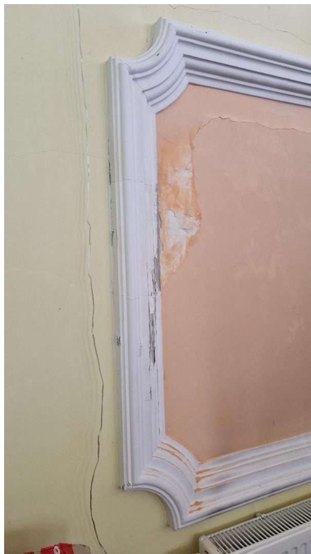
Fot. Zawilgocona wnęka i zniszczona sztukateria wewnętrzna. Stan zachowania na 2024 r.
