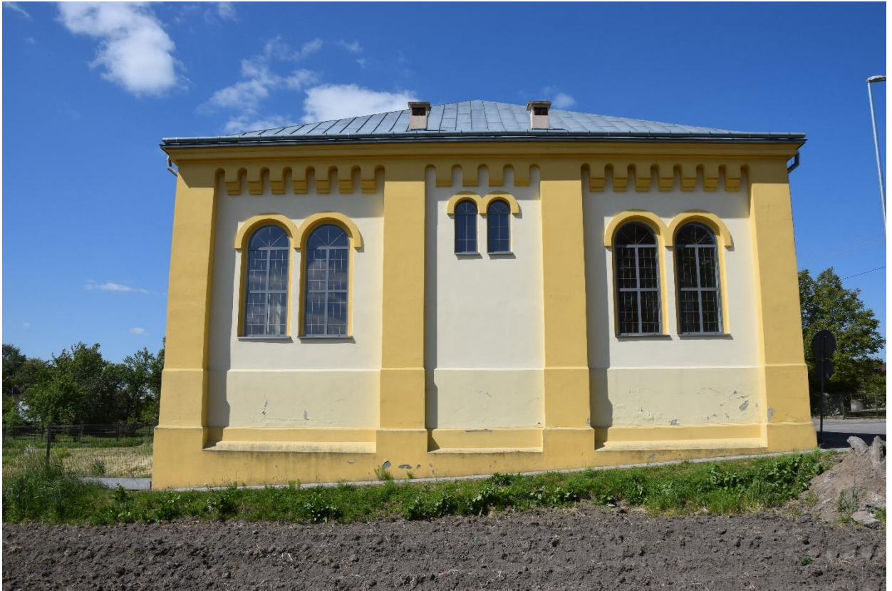
Fot. Elewacja wschodnia budynku. Stan zachowania na 2024 rok.
