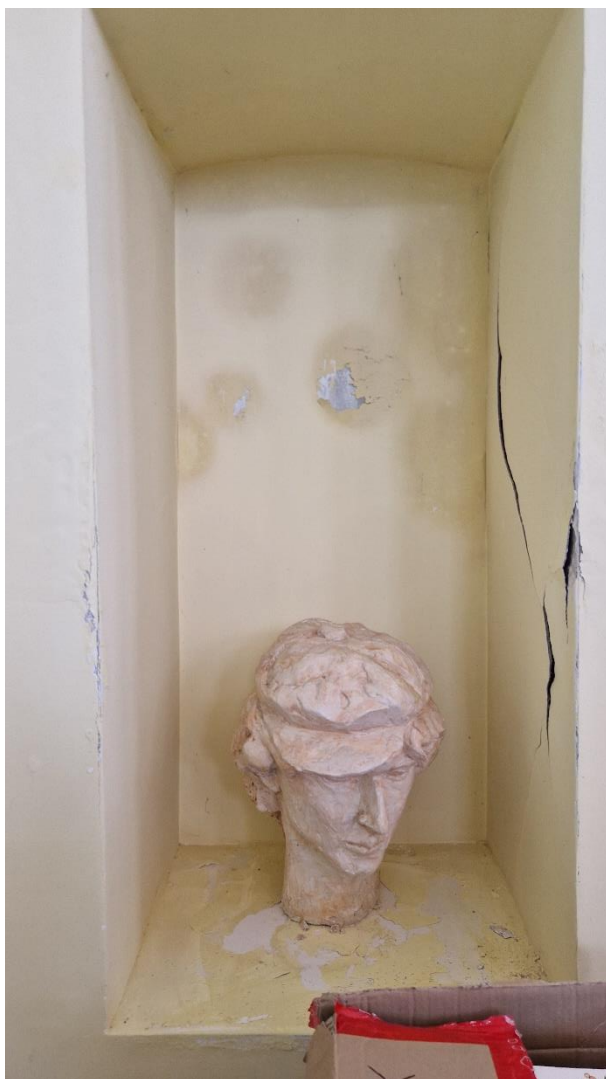
Fot. Zawilgocona wnęka i zniszczona sztukateria wewnętrzna. Stan zachowania na 2024 r.
