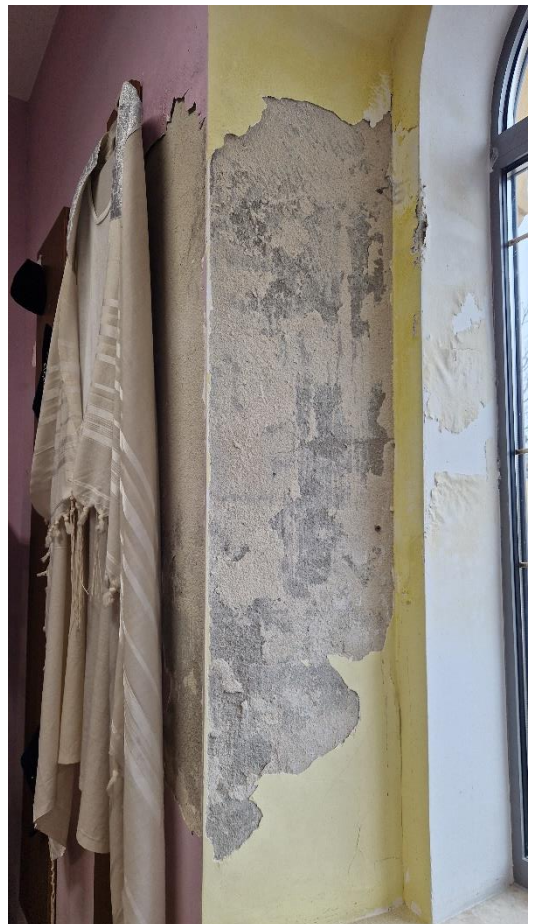
Fot. Odspojony tynk wewnątrz budynku. Stan zachowania na 2024 r.
