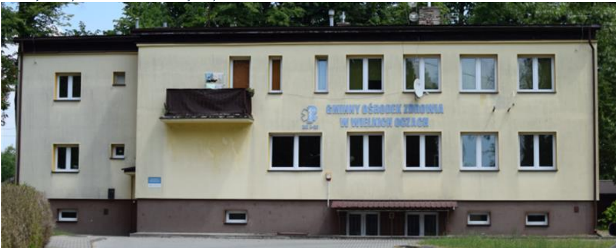
Ilustracja 7. Wymiana stolarki okiennej budynku ośrodka zdrowia w Wielkich Oczach
