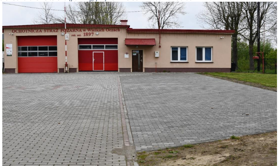
Ilustracja 6. Utwardzenie terenu (parking) przy remizie OSP w Wielkich Oczach
