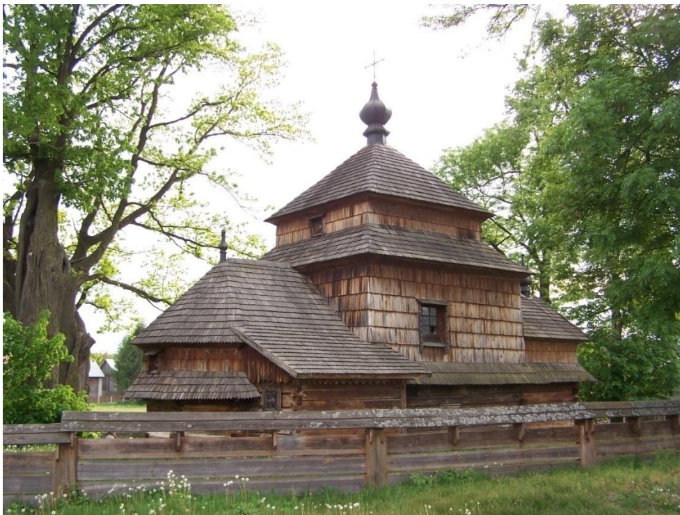
Fotografia 7 - Cerkiew w Łukawcu
