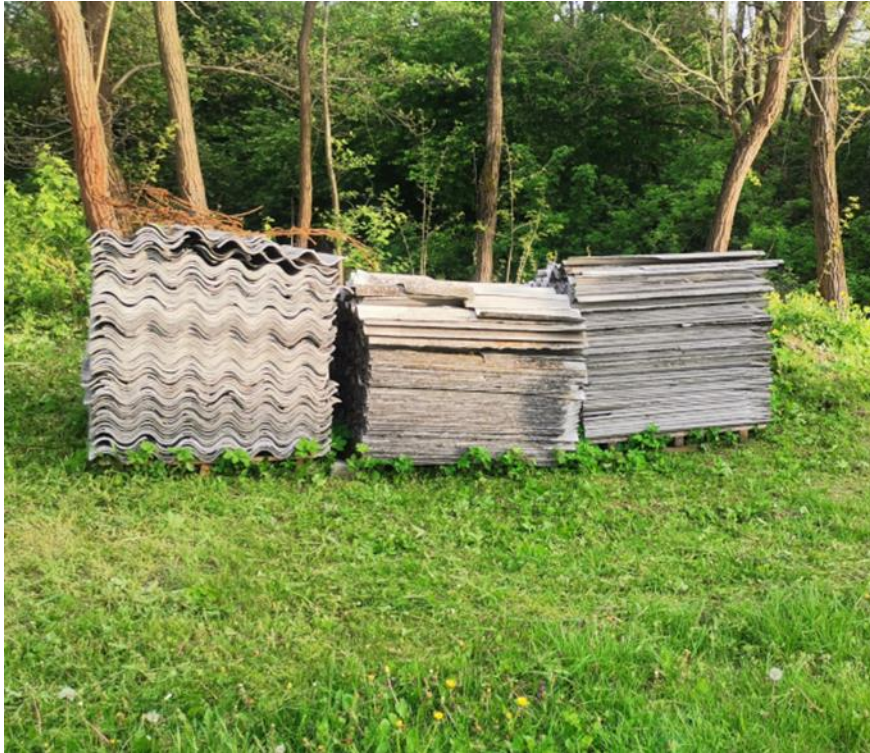
Fot. 3 Sposób przygotowania zdemontowanych płyty azbestowych na paletach do łatwego transportu. Dla prawidłowego zabezpieczenia w kolejnym kroku powinny zostać szczelnie owinięte np. czarną folią stretch-ową. Zdjęcie własne.
