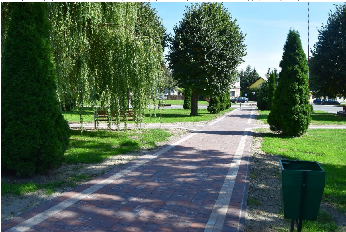
Ilustracja 6. Zagospodarowanie przestrzeni publicznej Rynku w miejscowości Wielkie Oczy poprzez wymianę chodnika
