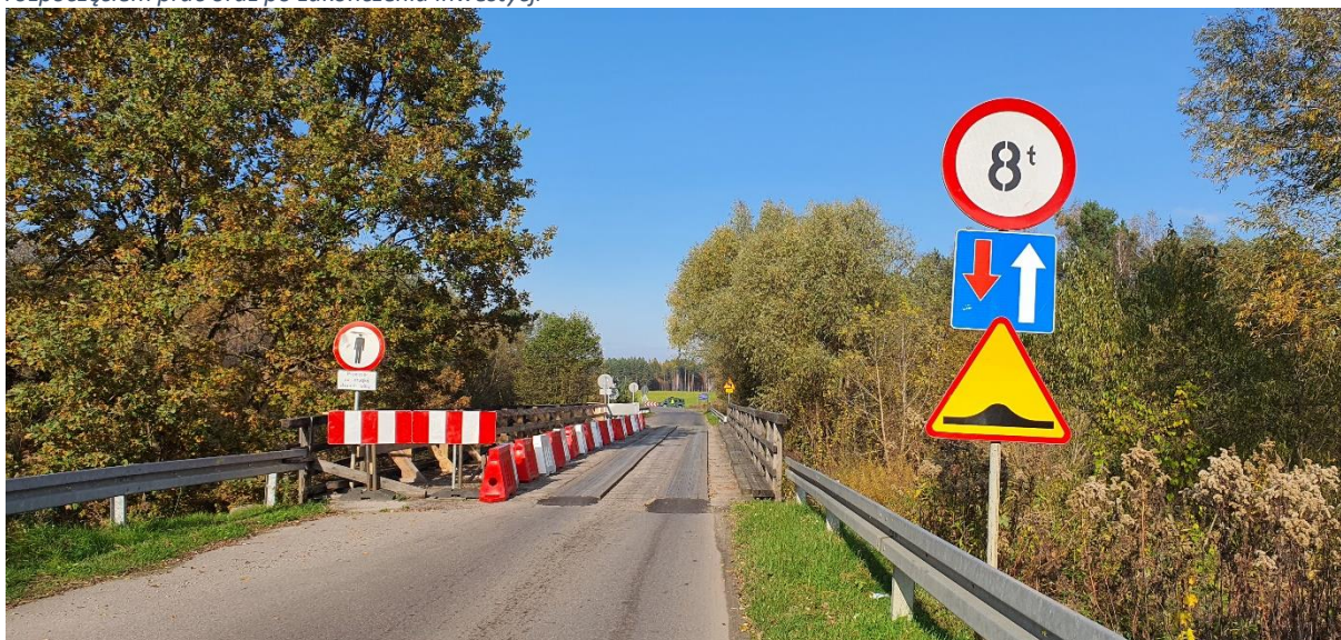
Ilustracja 10. Przebudowany most na rzece Szkło w ciągu drogi powiatowej nr 1698R w miejscowości Budzyń. Zdjęcie przed rozpoczęciem prac oraz po zakończeniu inwestycji
