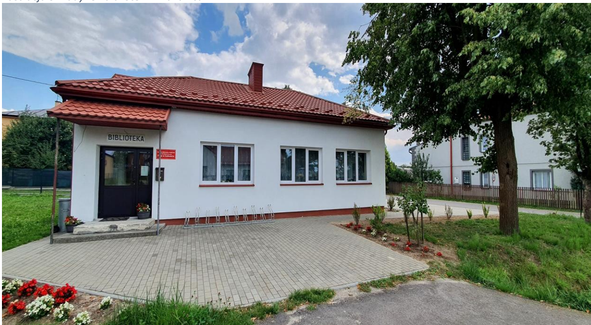
Ilustracja 5. Budynek biblioteki w Łukawcu
